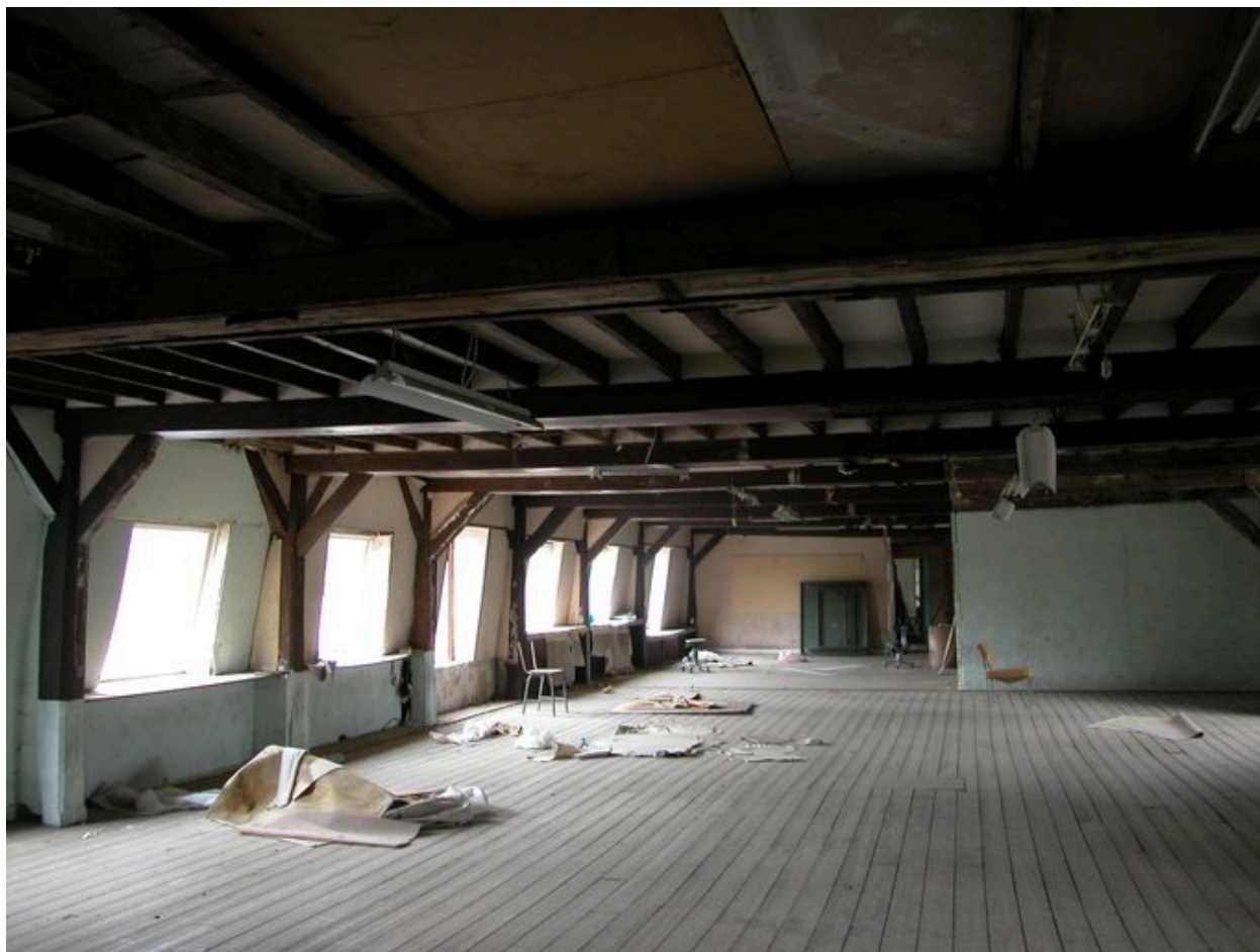
Intérieur de l'étage sous comble de l'atelier de filature.
