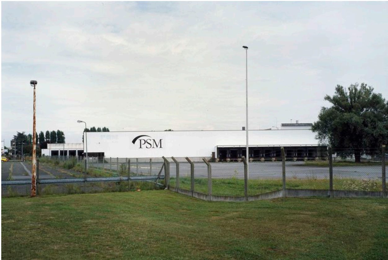
Vue générale du site de la papeterie.
