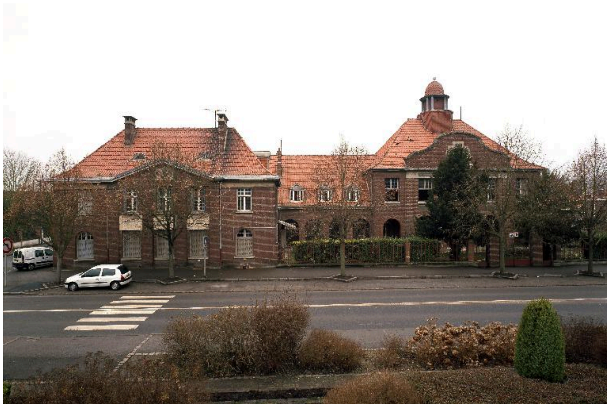
Vue générale de la façade, avenue Danicourt.
