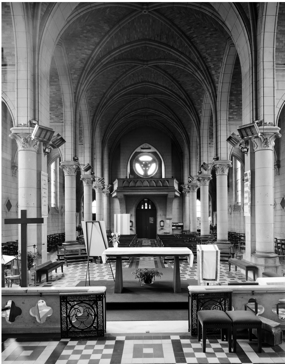
Vue générale intérieure vers l'entrée.
