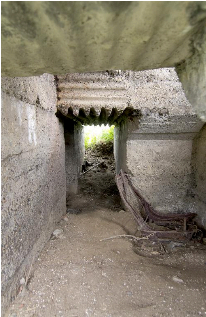
Couloir de distribution en enfilade vers le nord-est
