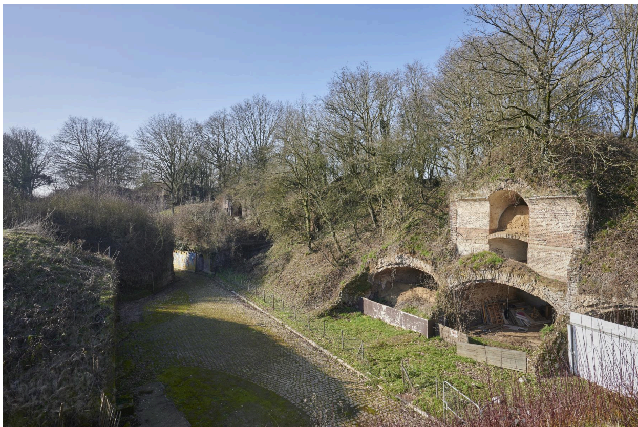
Aile est. Crête d'artillerie, vers le nord-ouest.
