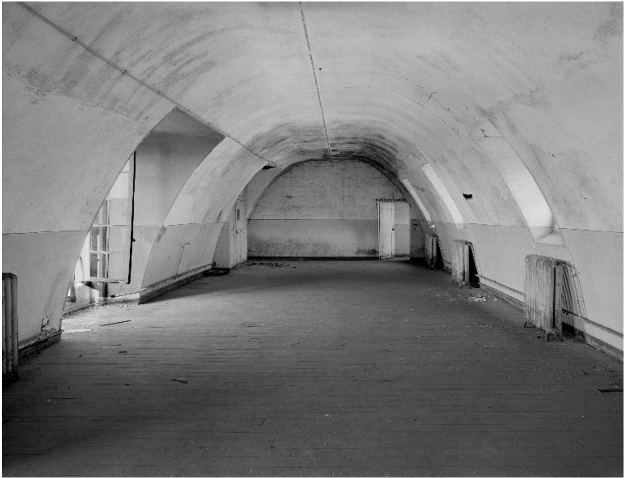
Vue de l'ancienne voûte de la chapelle, entresolée à la fin du 18e siècle.
