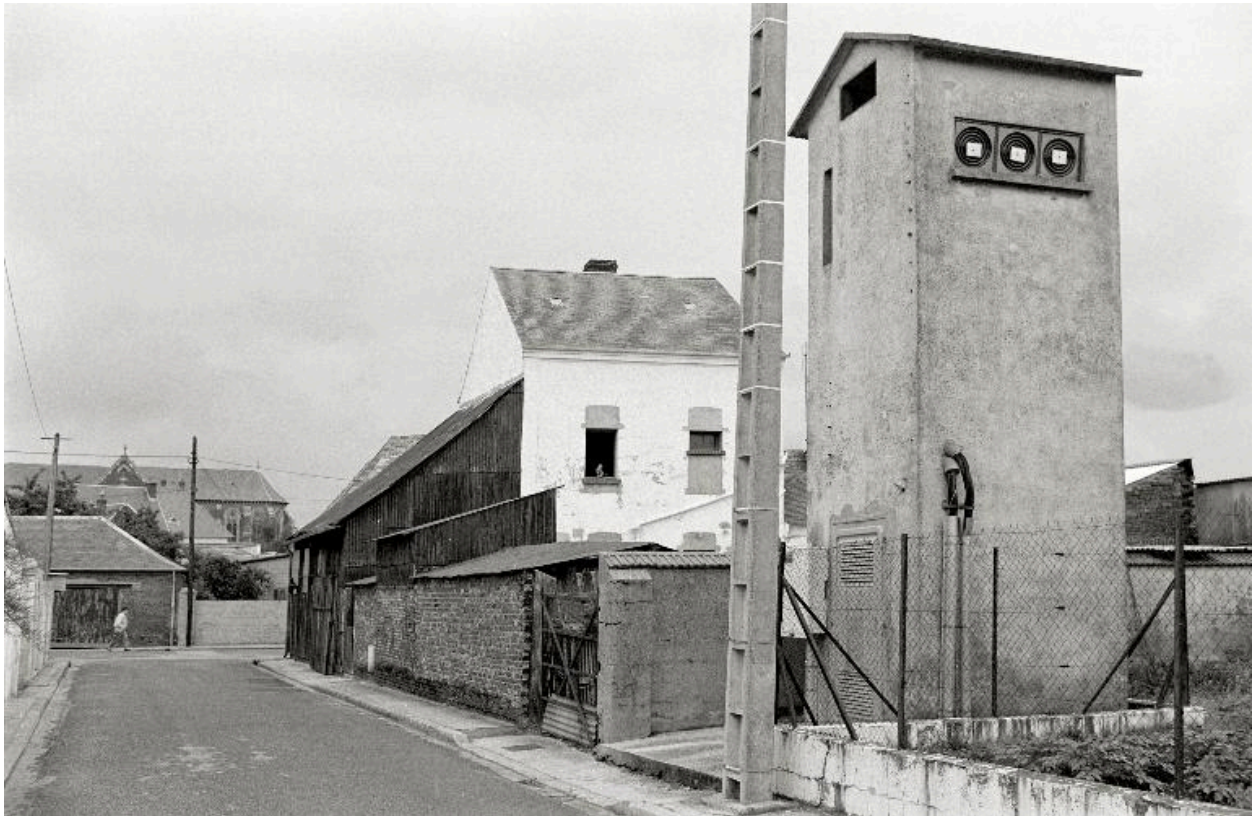
Élévation sud des anciens ateliers, 14 rue Voltaire.
