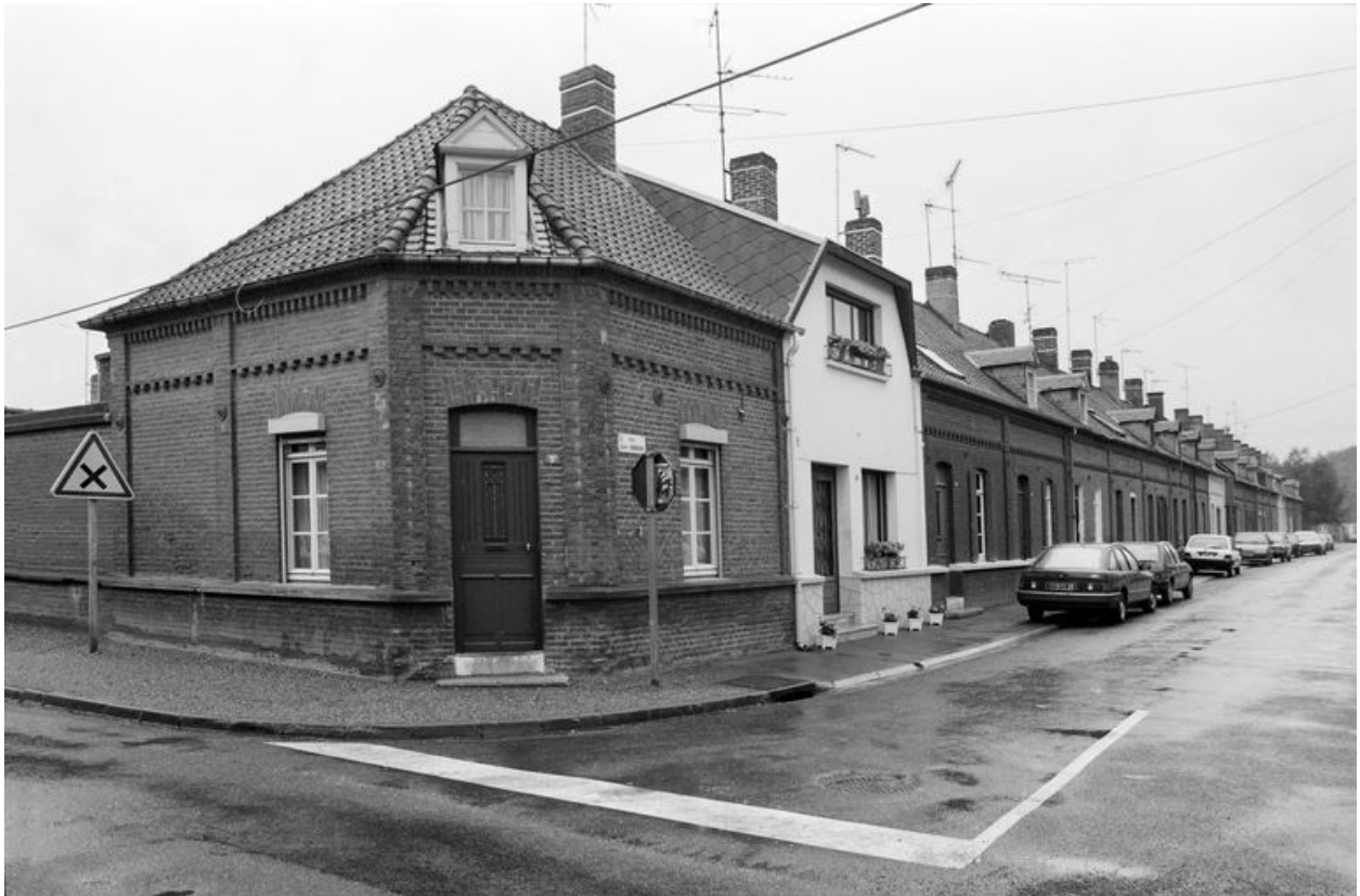
Vue de la rive sud de la cité Saint-Guillaume, en 1991.
