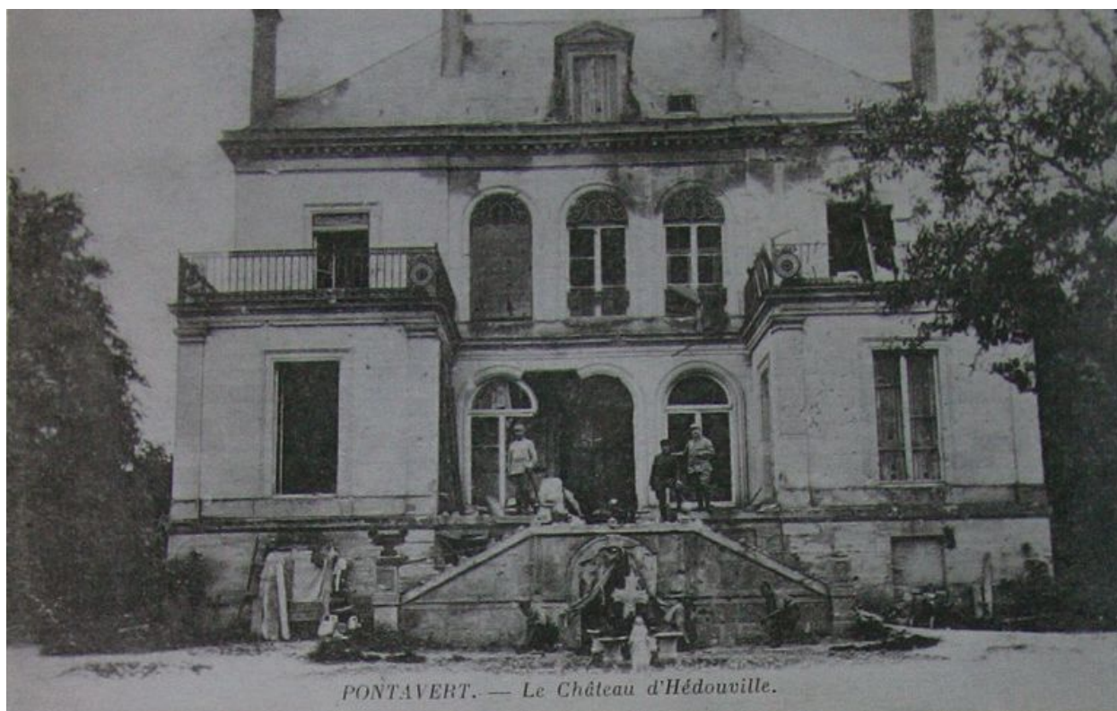
Grande-Rue. L'ancien château d'Hédouville, 1918 (coll. part).
