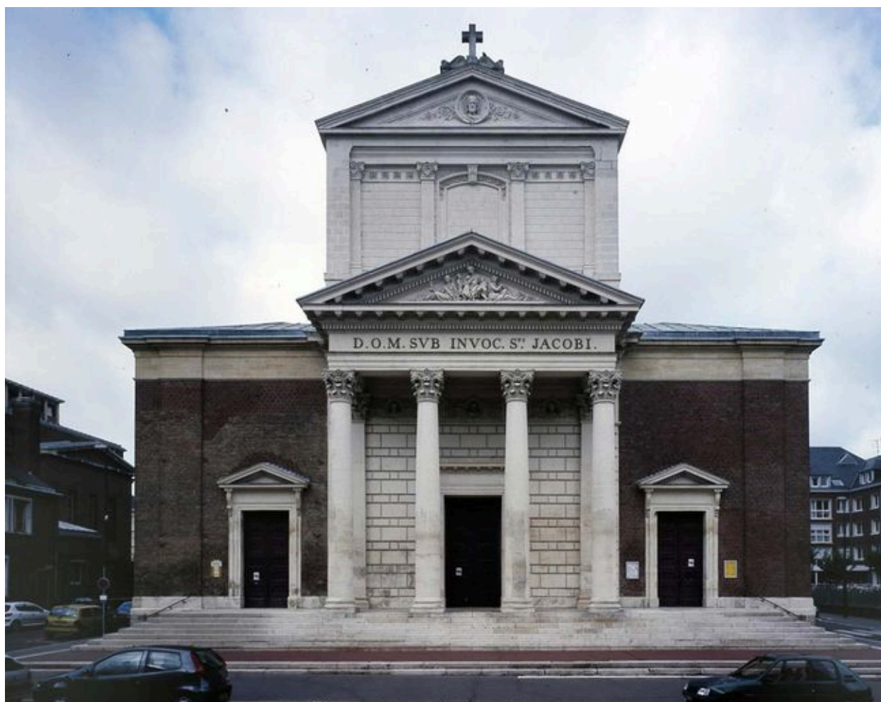
Eglise Saint-Jacques, façade antérieure.
