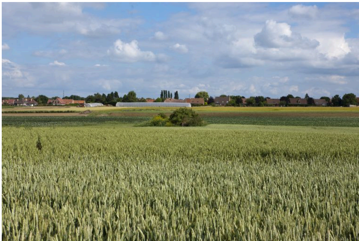
Casemates masquée sous la végétation à Ennetières-en-Weppes.
