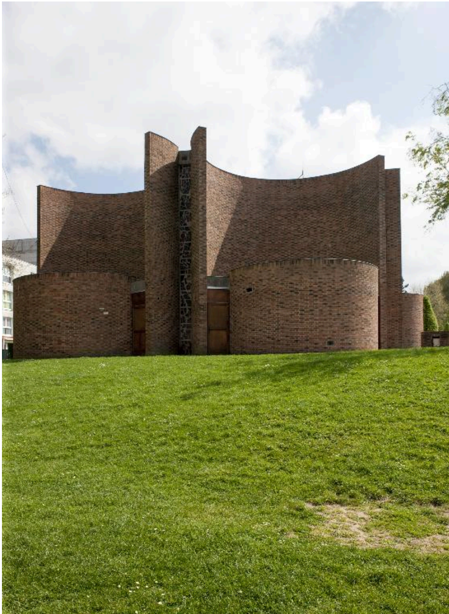
Élévation nord-ouest de l'église.
