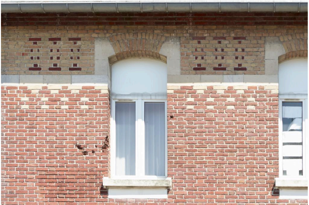
Détail du décor de brique des façades.
