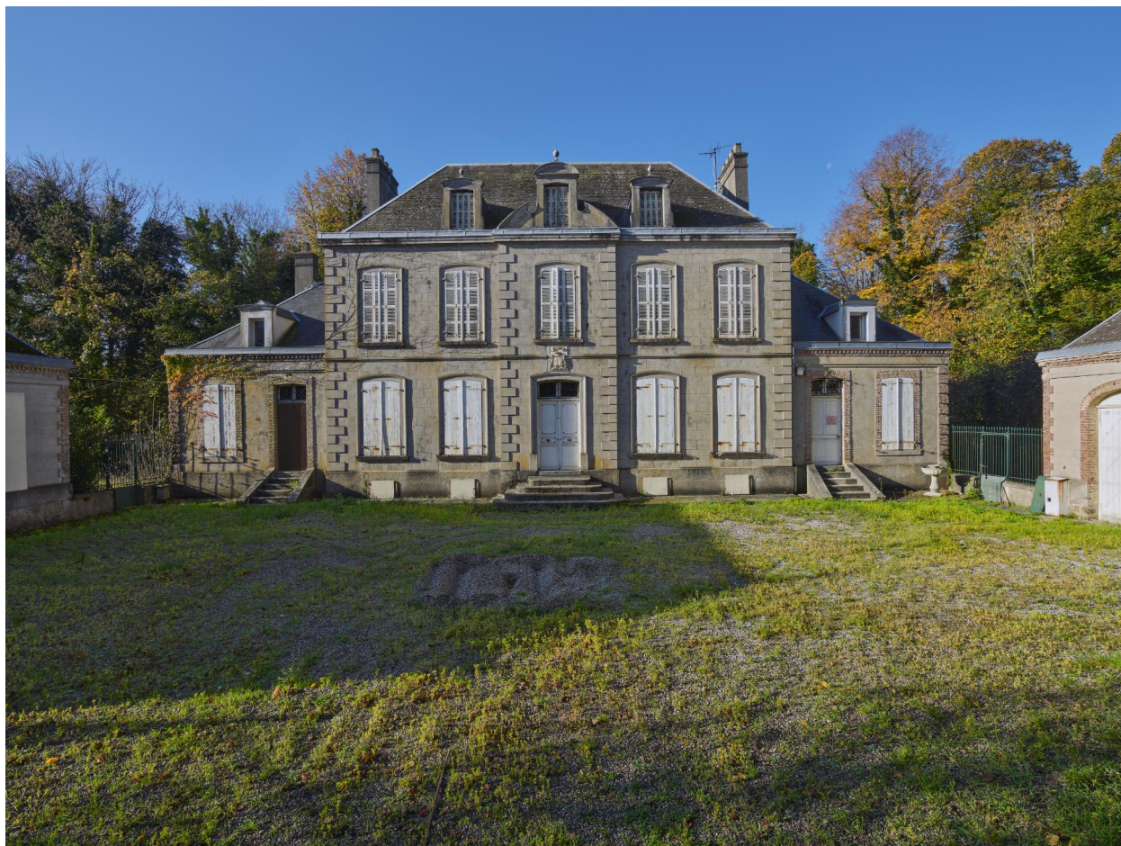
Vue générale du château du Rohart (élévation antérieure) prise depuis l'est.
