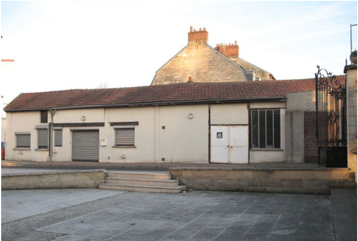
Un atelier de fabrication de la brasserie.
