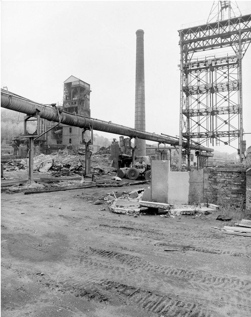
Vue d'ensemble (élévateur façade sud, conduites, portiques).
