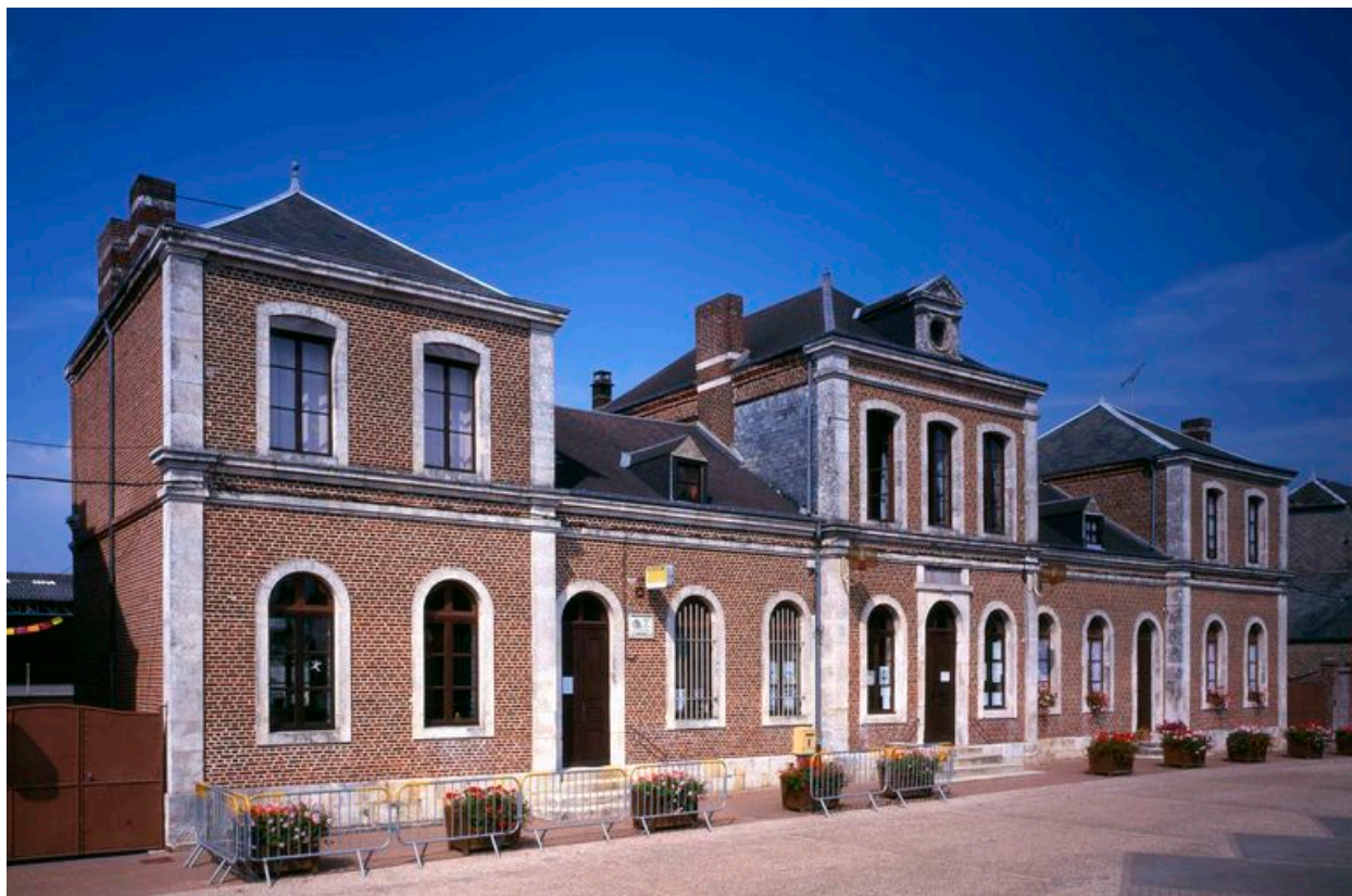
Vue générale depuis le sud ouest.
