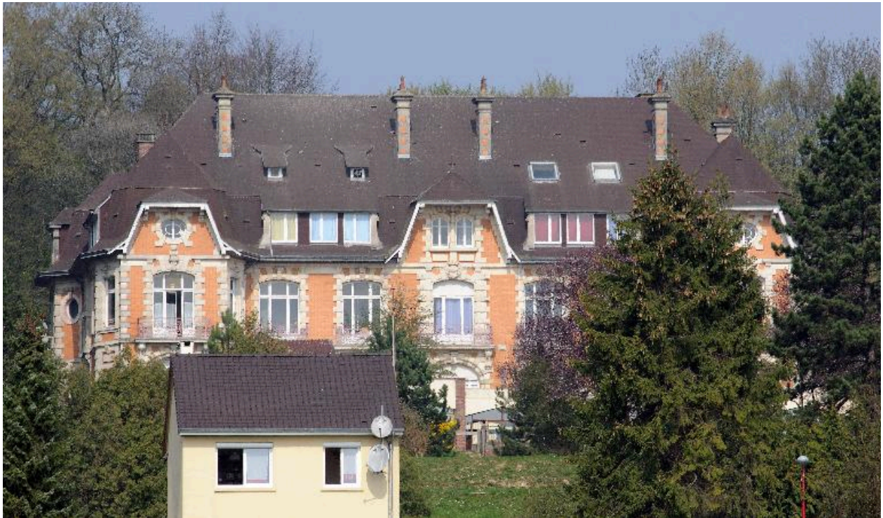
Vue de face du château.
