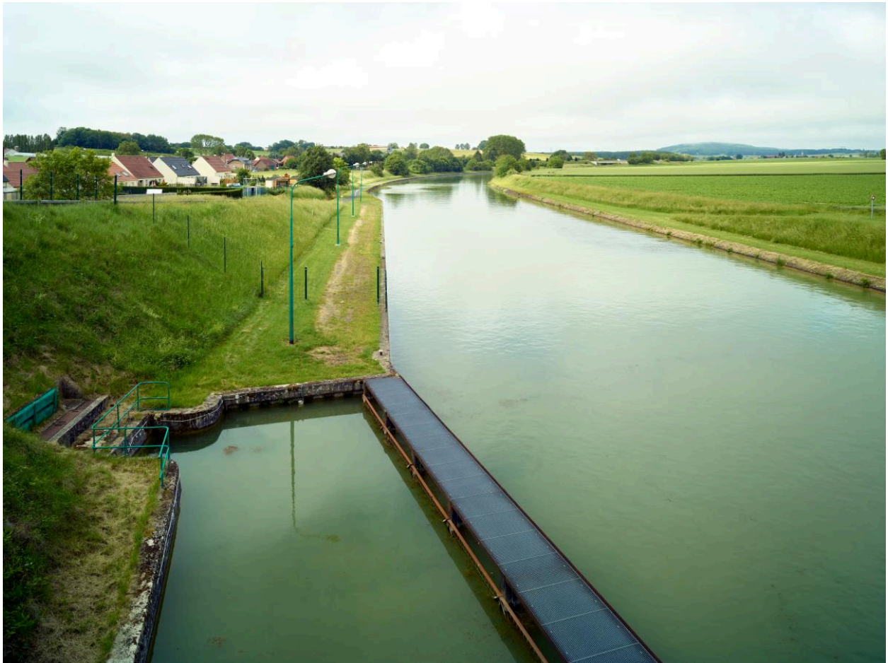
Le bassin de tranquillisation en aval du site.
