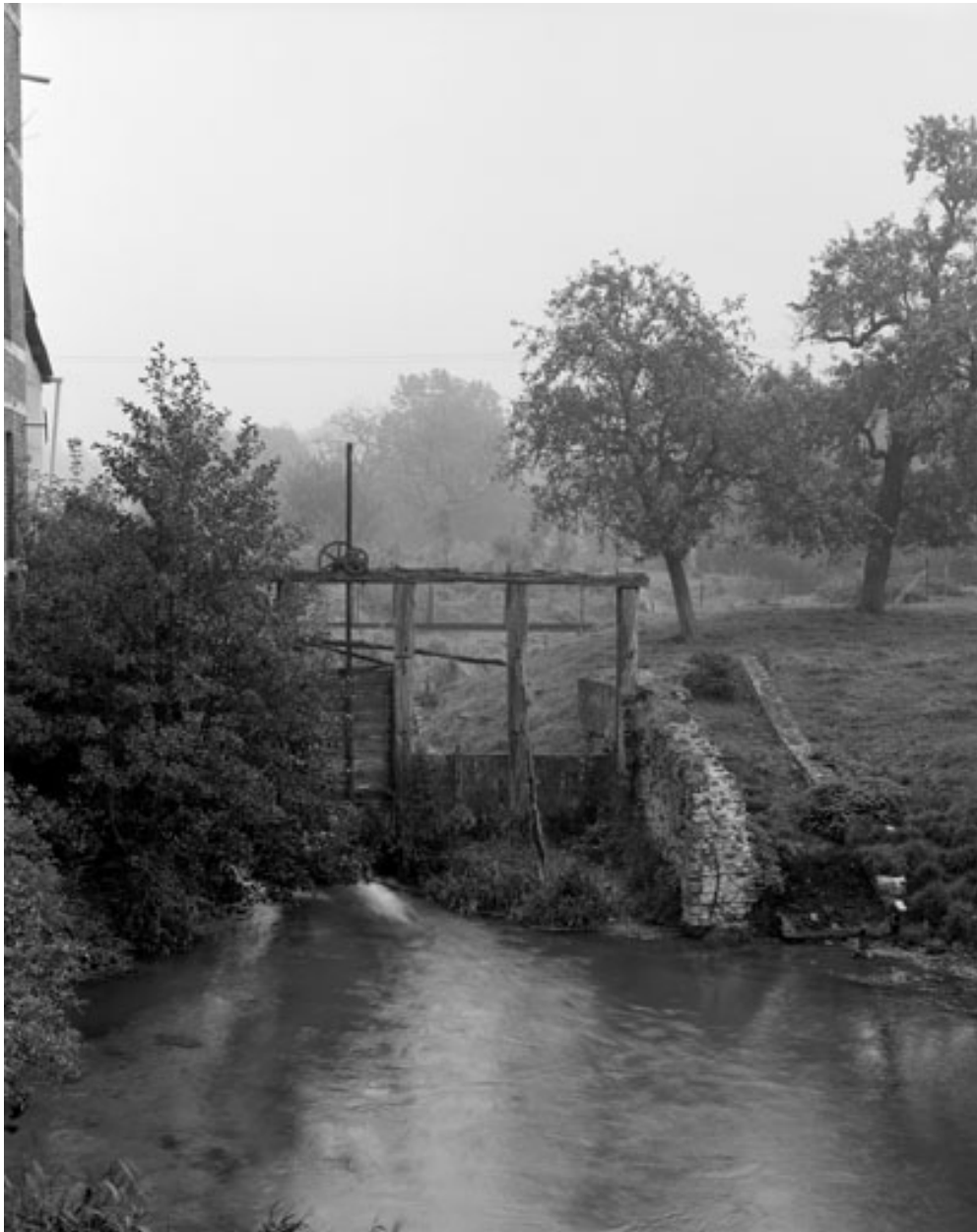
Vanne de décharge.
