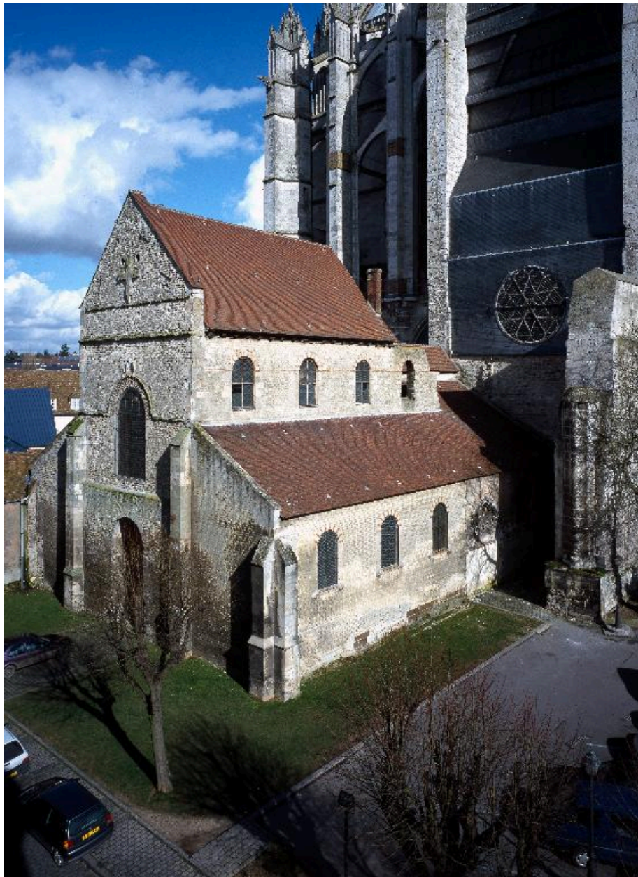
Vue générale, depuis la tour du palais épiscopal.
