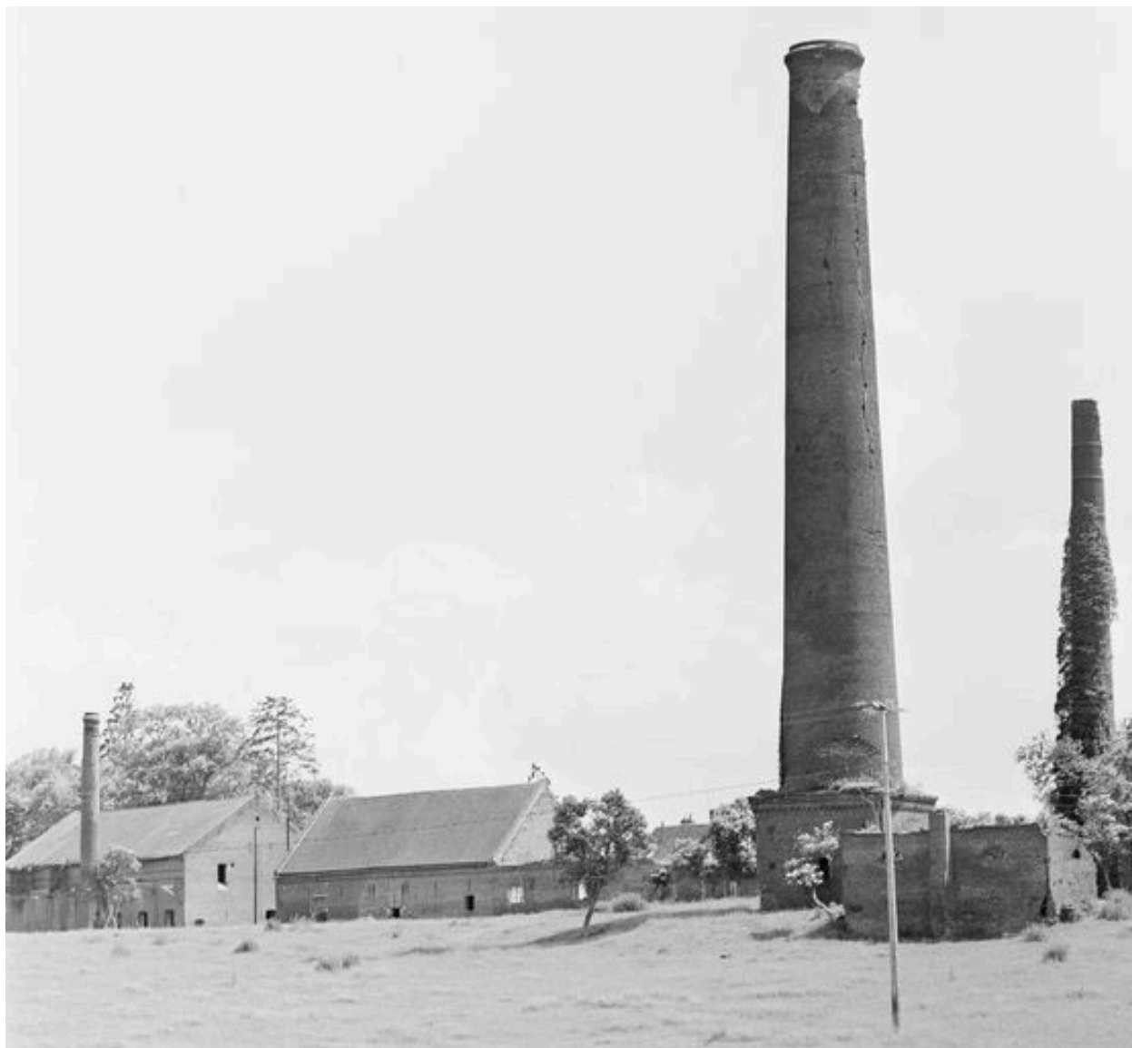
Cheminées d'usine, atelier de fabrication et remise.
