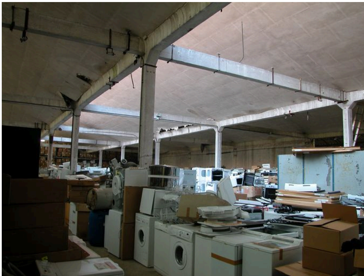
Intérieur de l'atelier de fabrication, détail des charpentes en béton armé.
