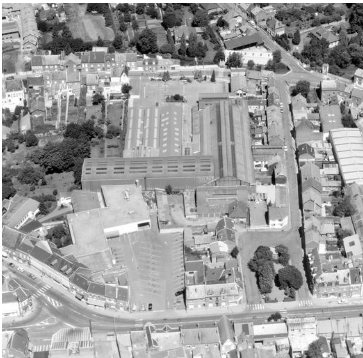
Vue aérienne, flanc sud.
