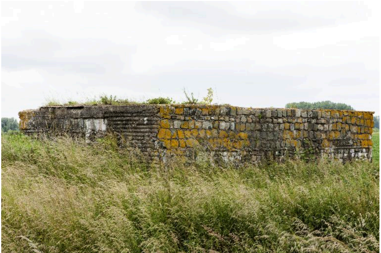
Vue de trois-quarts, vers le sud
