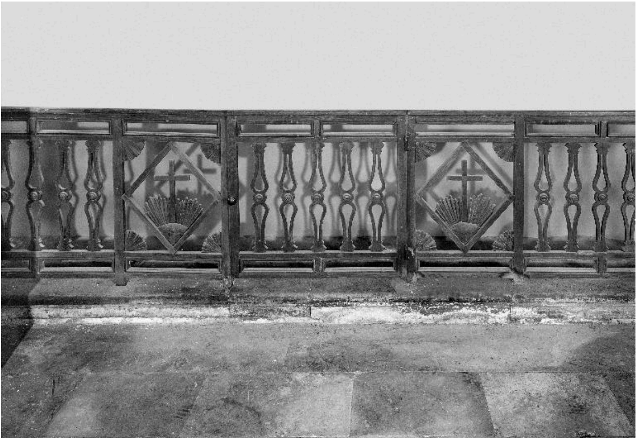
Vue partielle de la clôture des fonts baptismaux.
