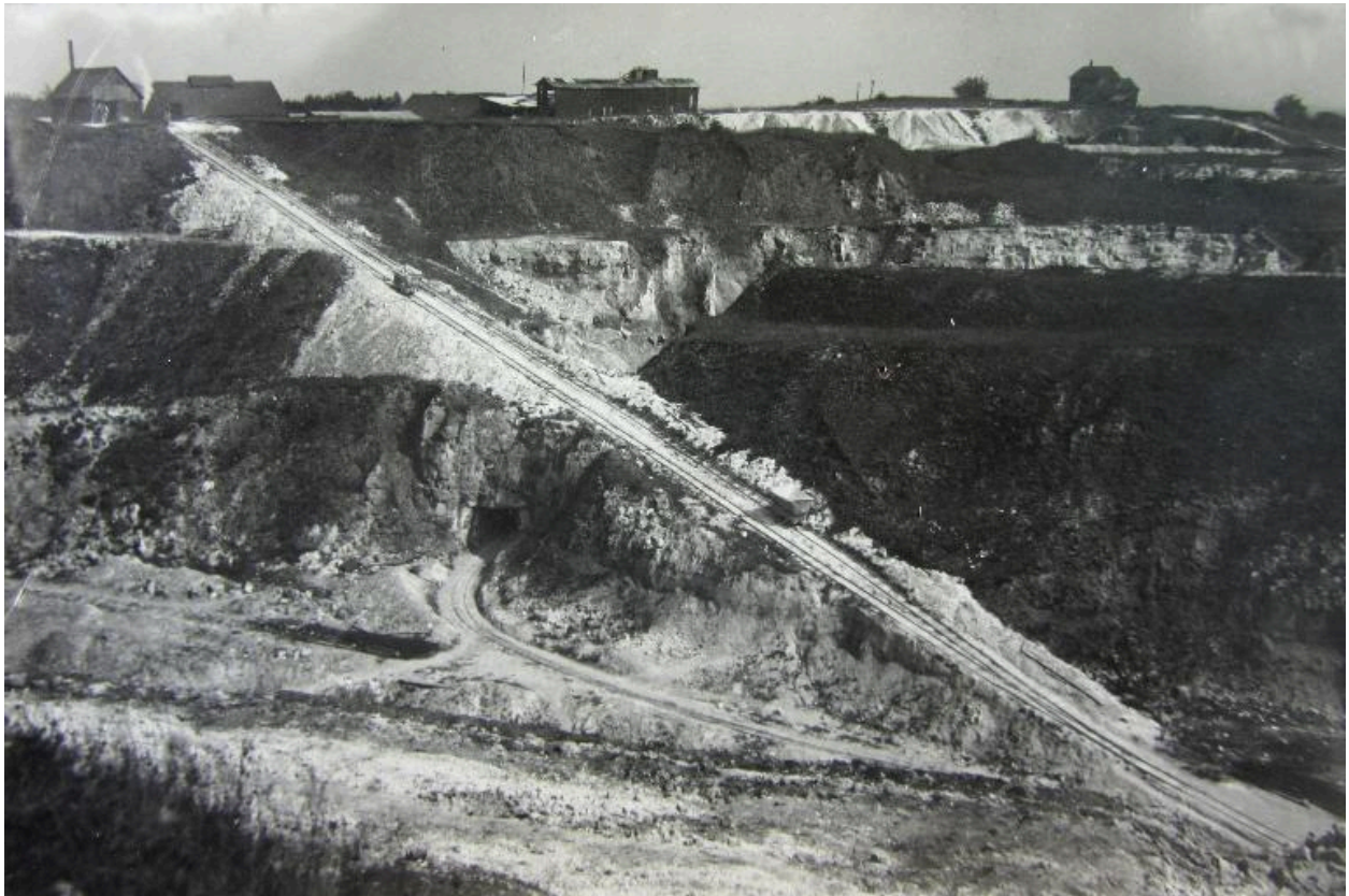
Vue d'ensemble de la carrière de phosphates et de ses rampes d'accès, début 20e siècle (coll. part.).
