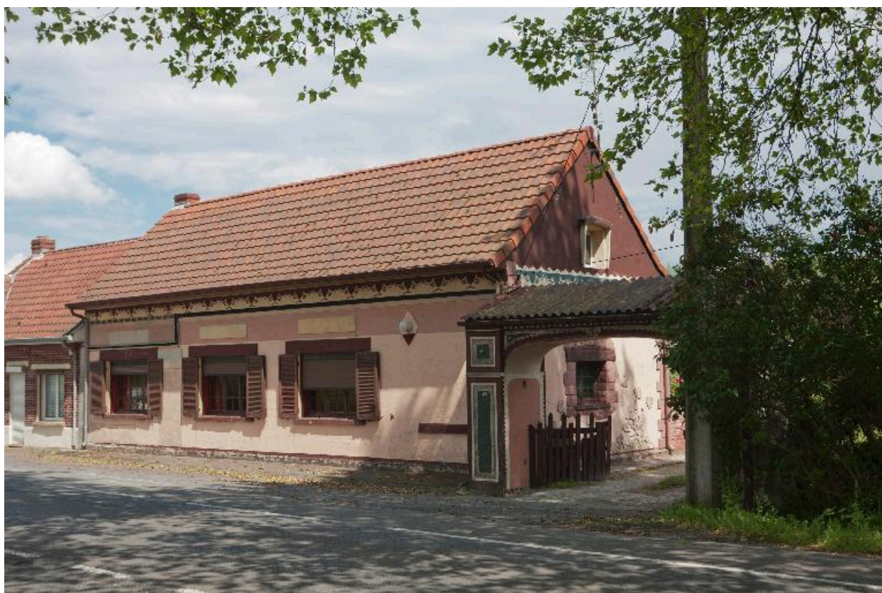
Vue générale sur rue.
