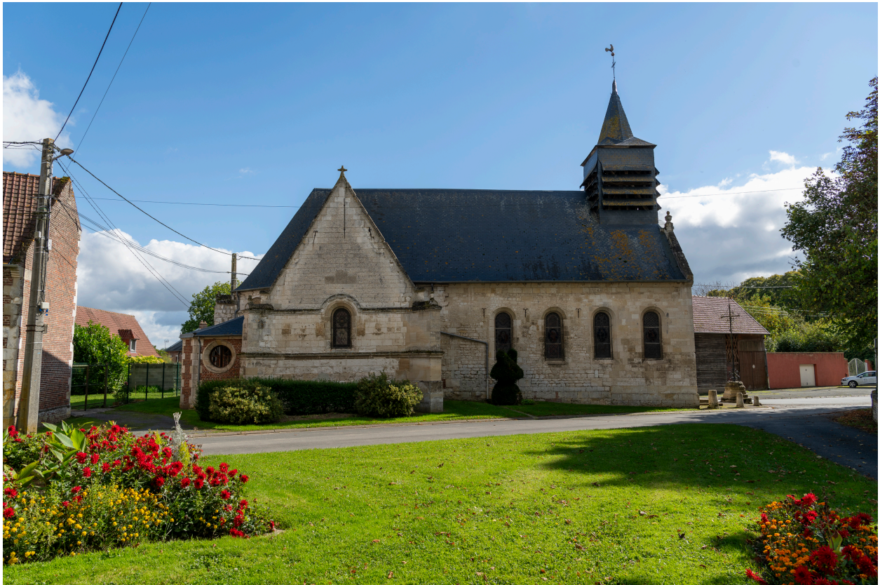
Vue générale de l'élévation nord.
