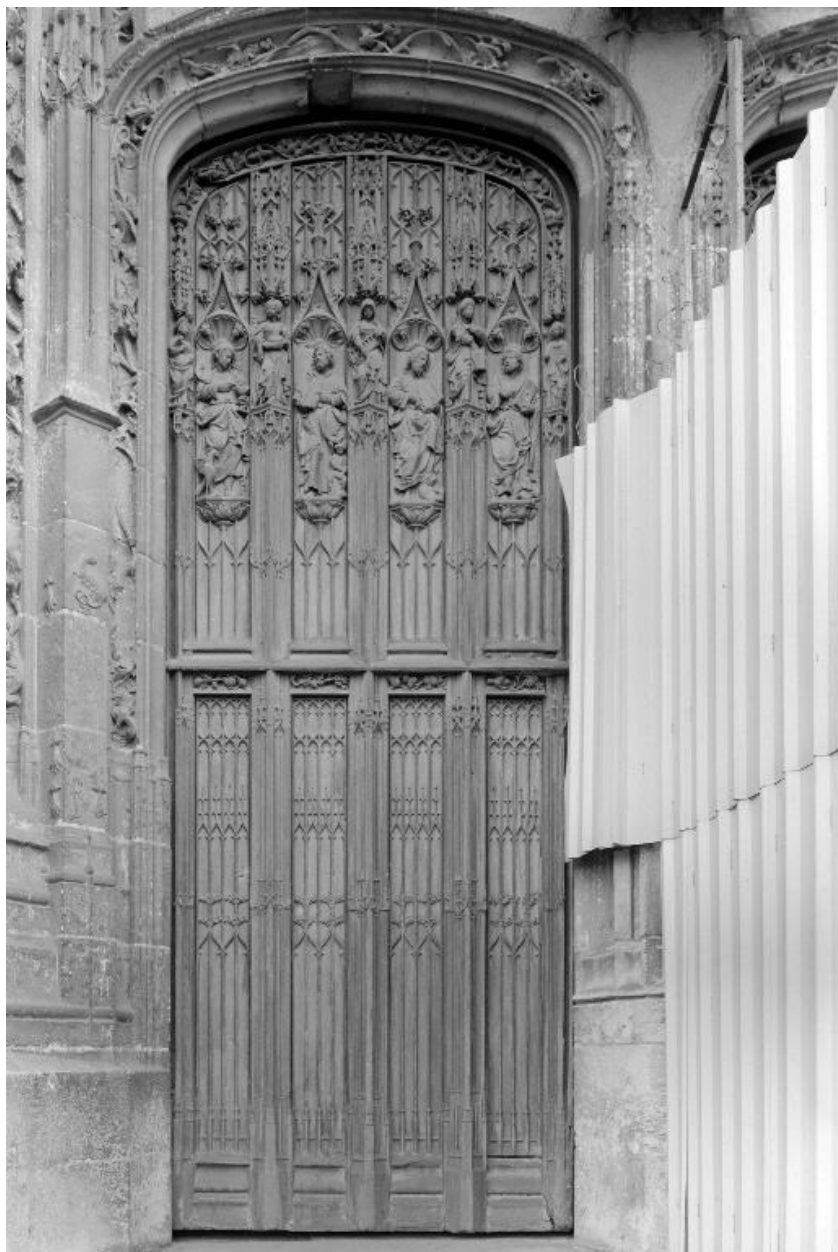
Vue du vantail gauche du portail nord.
