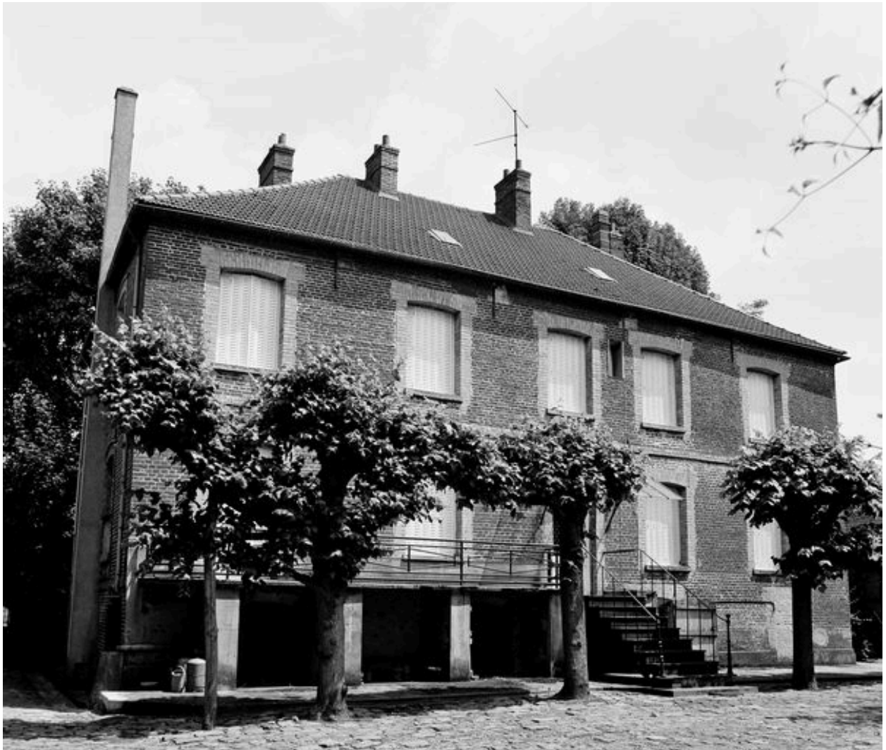
Logement patronal : façade antérieure.
