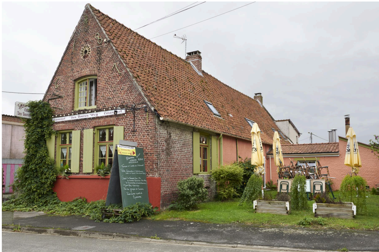
Pignon est et façade nord.
