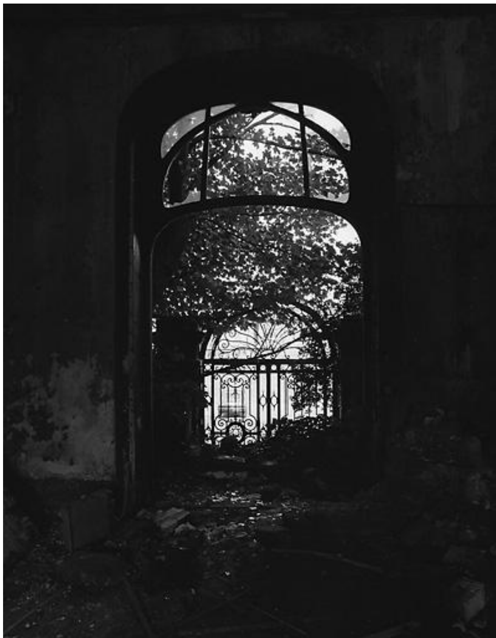
Façade sur voie, porte-fenêtre (ferronnerie).
