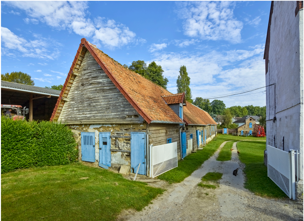
Vue de l'entrée de la cour, depuis le sud.
