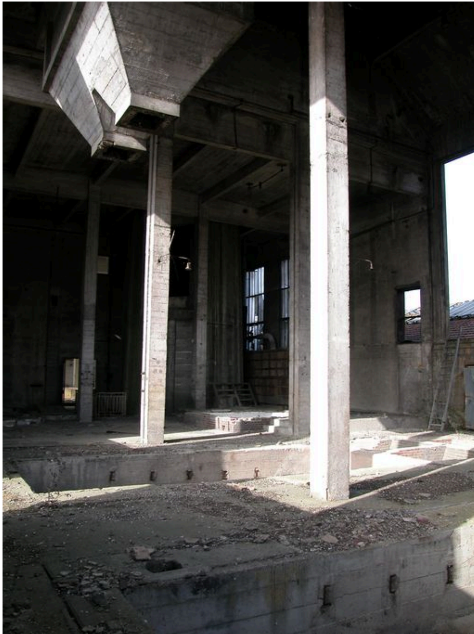
Intérieur du premier étage de la chaufferie.
