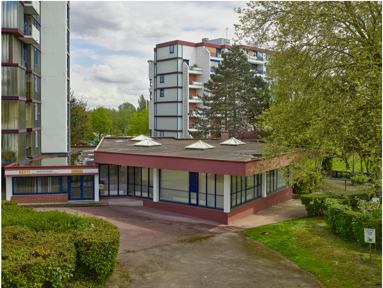
Bâtiment K à usage de commerces et bureaux (aujourd'hui MFR).
