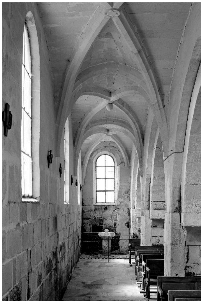
Vue du bas-côté sud, prise d'est en ouest.
