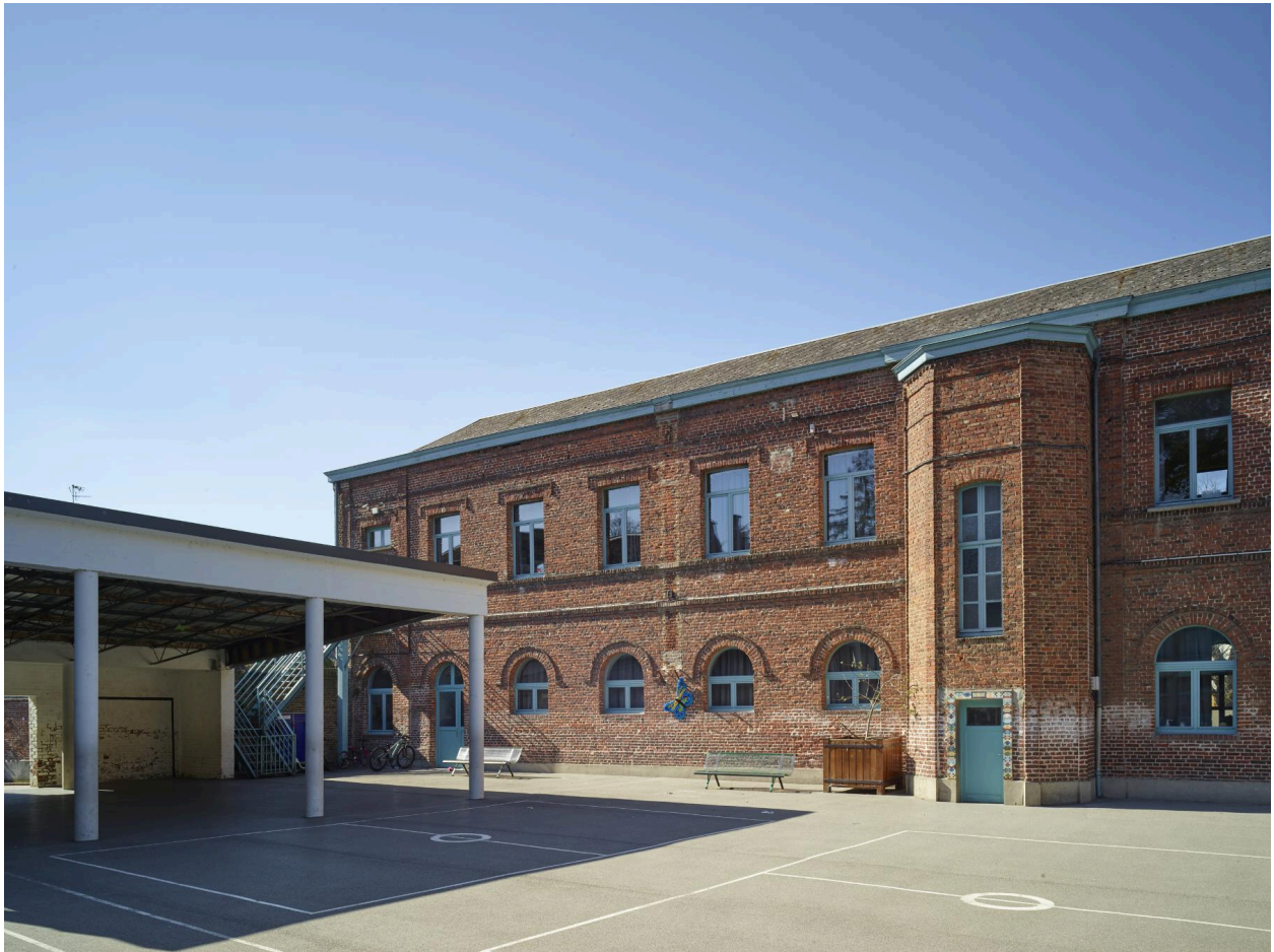
École de garçons : façade arrière donnant sur l'actuelle cour du bâtiment construit en 1850 par l'architecte Casimir Pétiaux pour abriter les dortoirs du collège. Détail de la partie sud-ouest. Vue orientée sud-est/nord-ouest.
