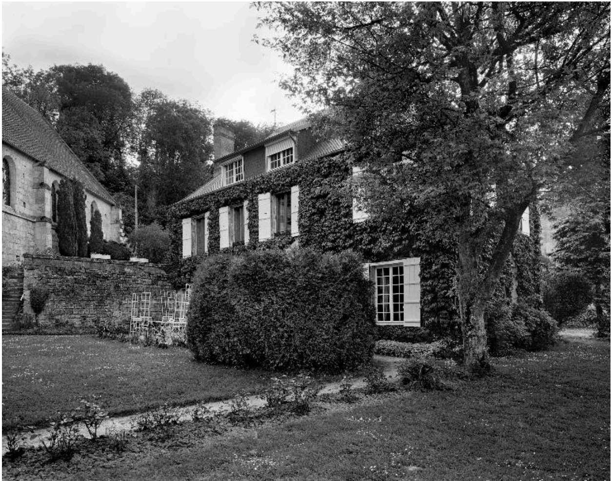
Vue de l'ancien presbytère depuis l'est.
