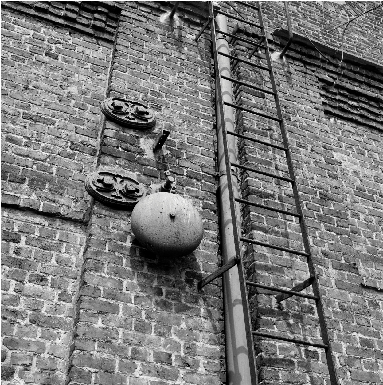
Magasin industriel. Élévation sud. Détail.
