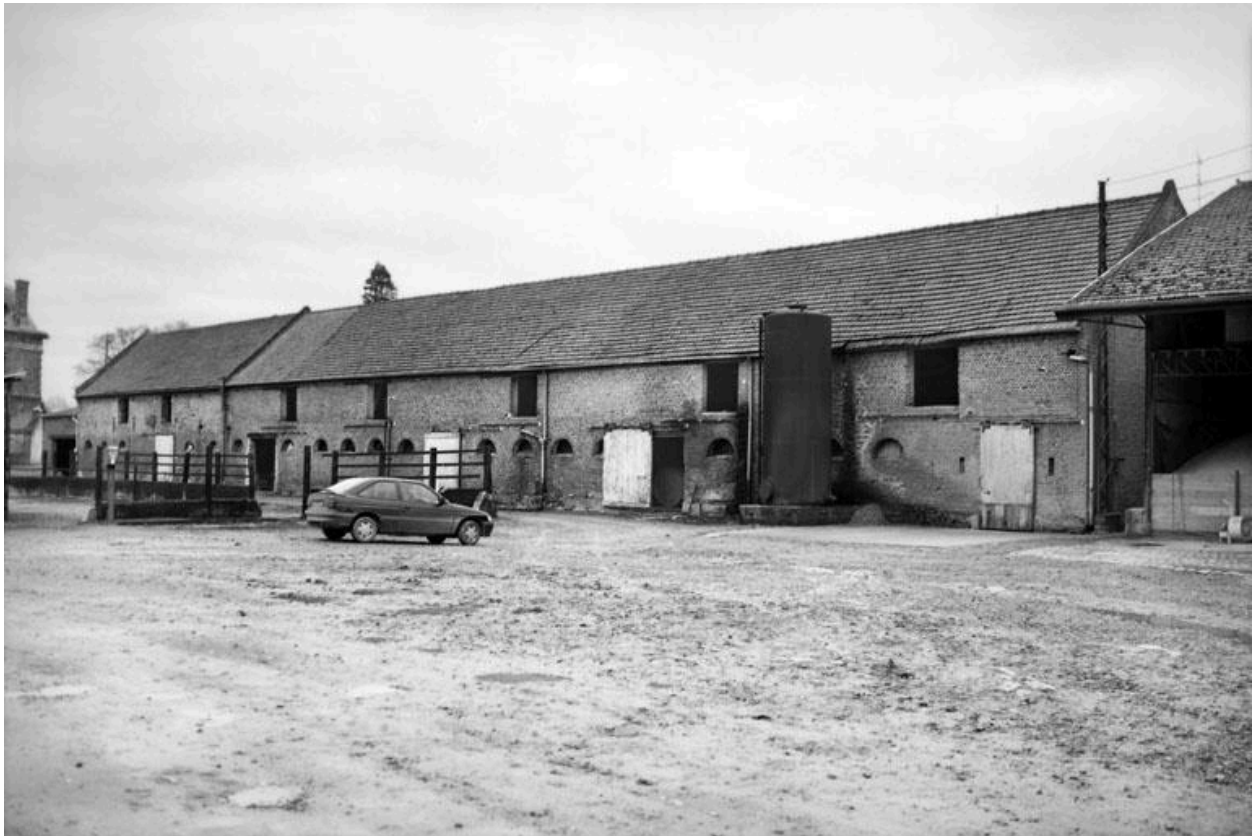
Vue de la grange et des remises, dans la cour.
