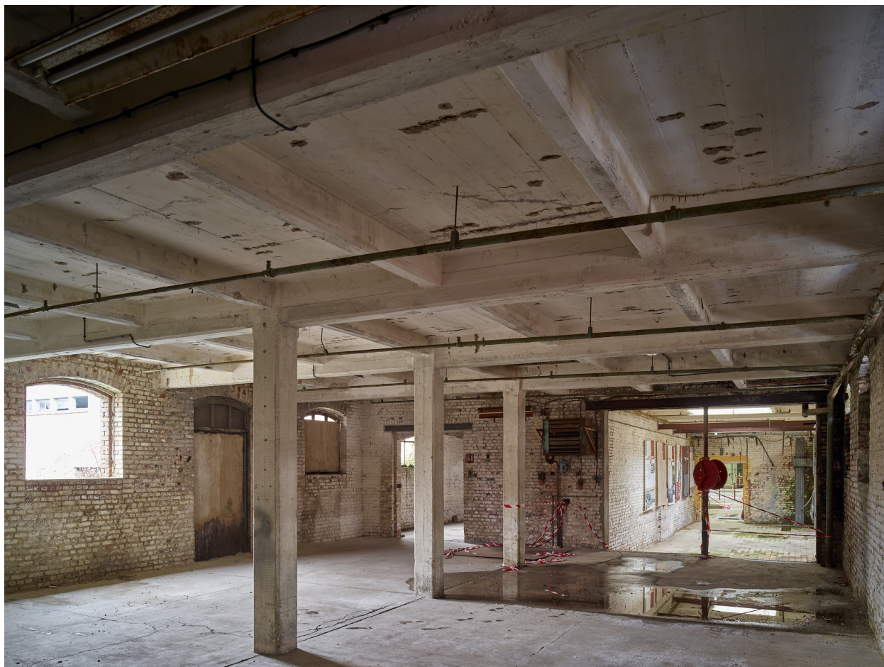
Le magasin industriel, vue vers le nord depuis l'angle sud-est.
