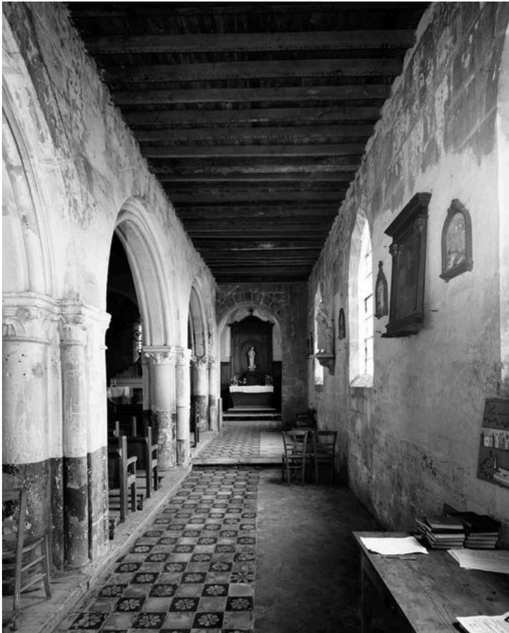
Vue intérieure du bas-côté sud d'ouest en est.
