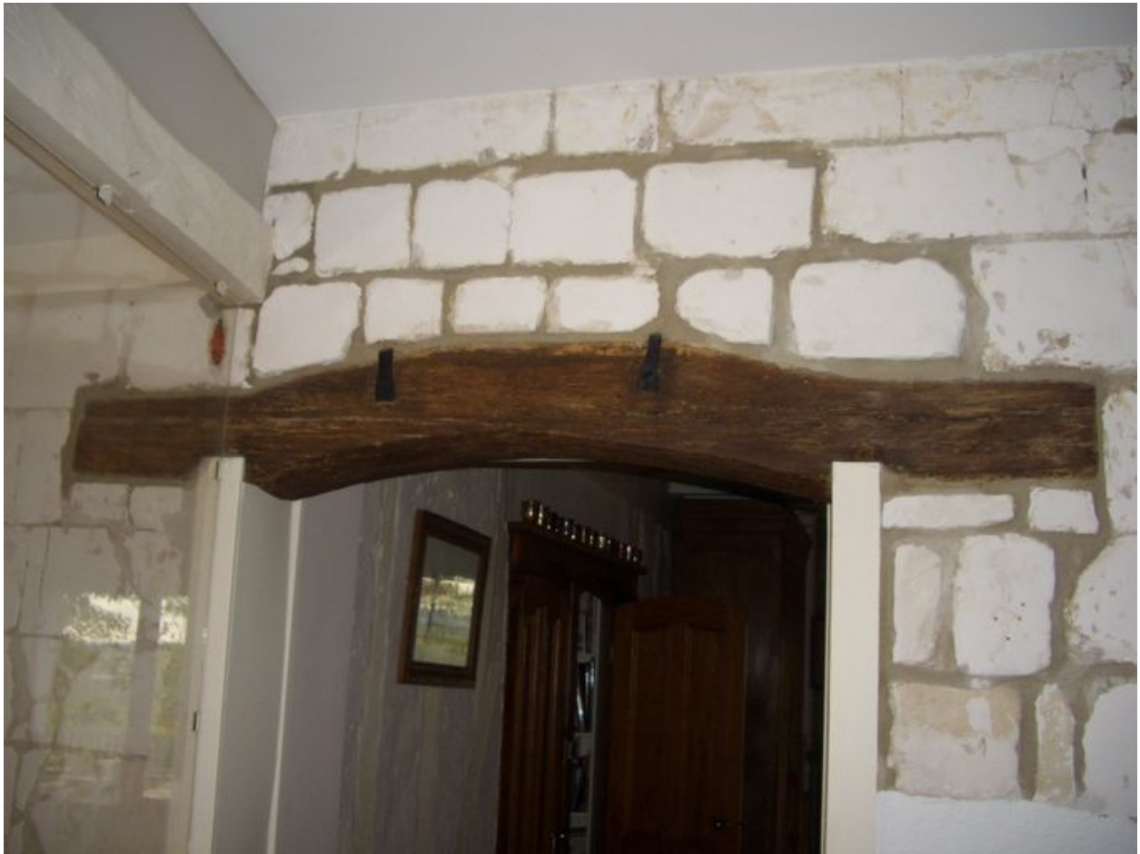
Vue de l'un des linteaux des ouvertures du logis.
