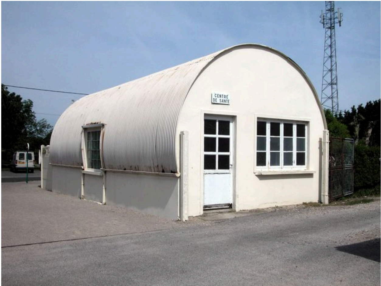
Le dispensaire, construction type de l'après-guerre.
