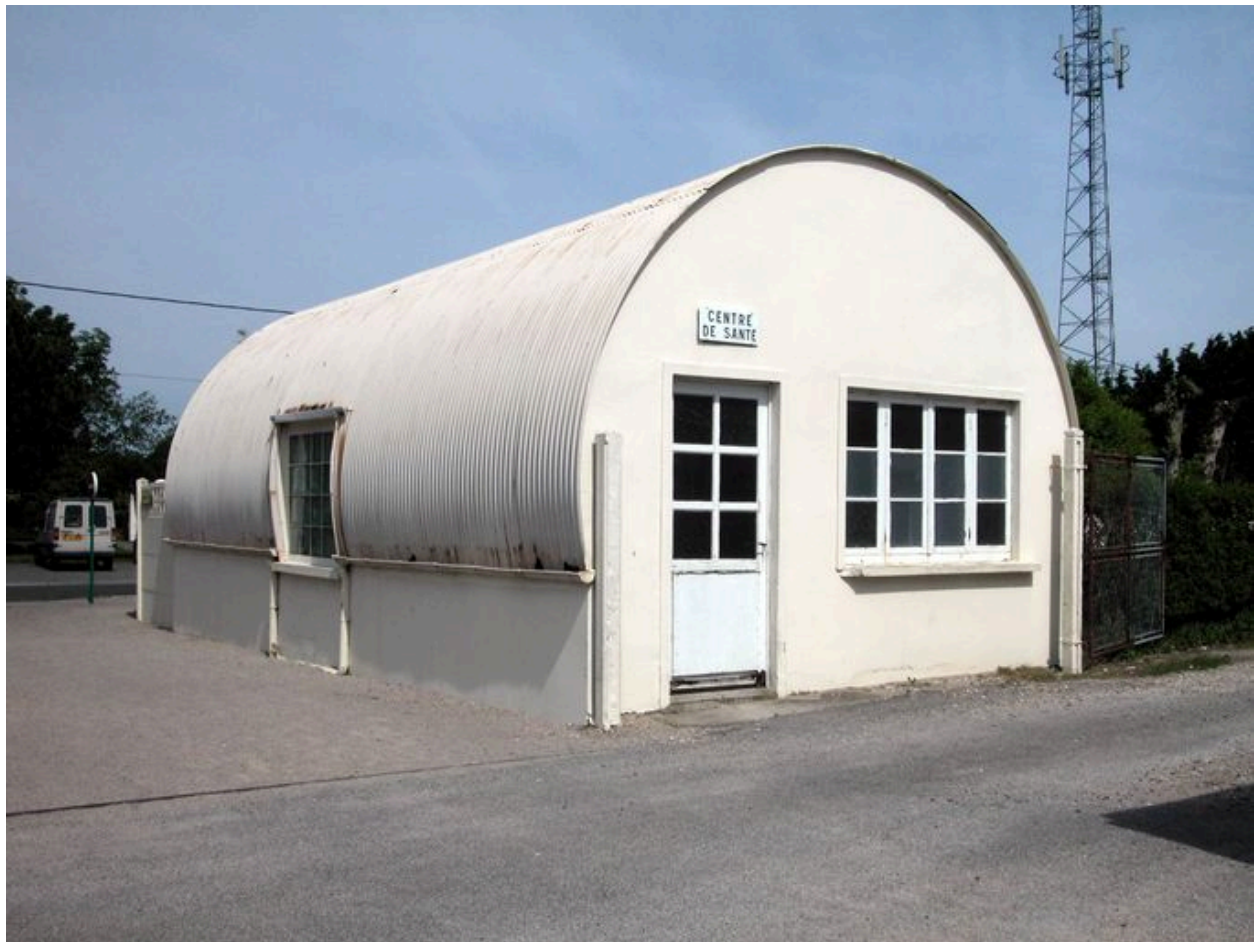
Le dispensaire, construction type de l'après-guerre.
