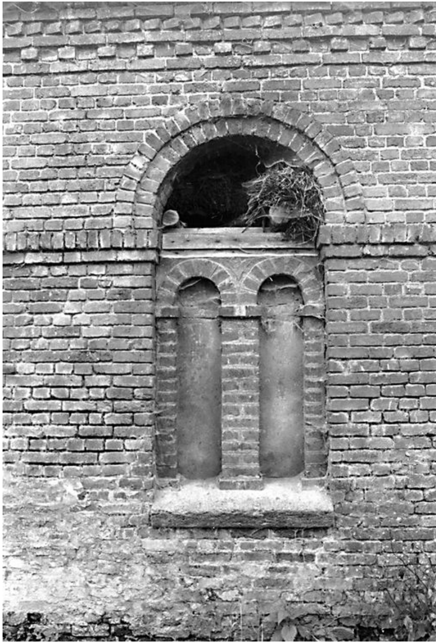
Elévation nord de la grange : détail d'un motif architectural antiquisant.
