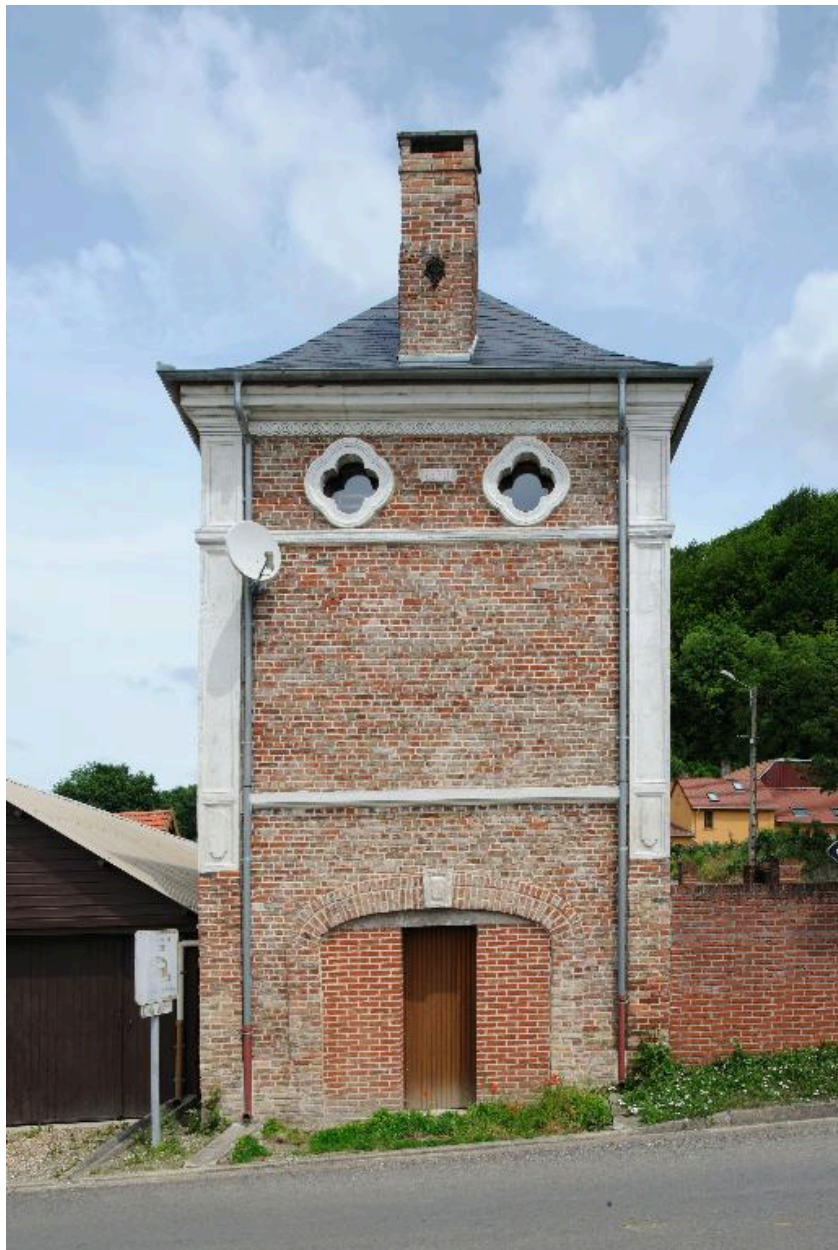
Vue d'ensemble du pignon sud.
