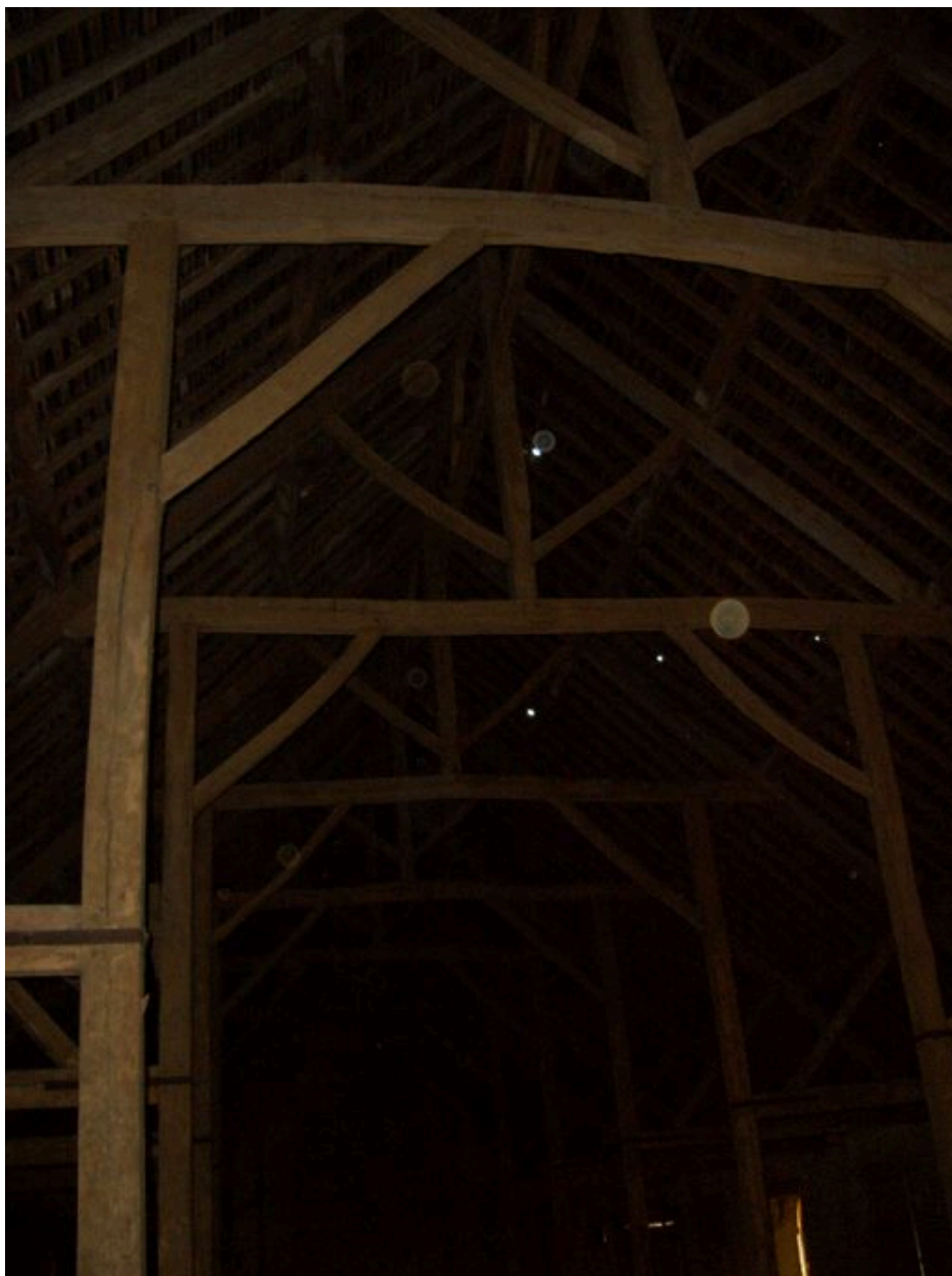
Vue partielle de la charpente des bouveries.
