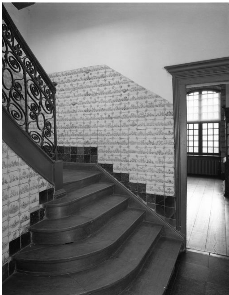
Bâtiment de la communauté religieuse, rez-de-chaussée, escalier, départ : revêtement mural en carreaux de faïence de Lille.
